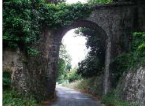
Ancien pont des chemins de fer de Provence
